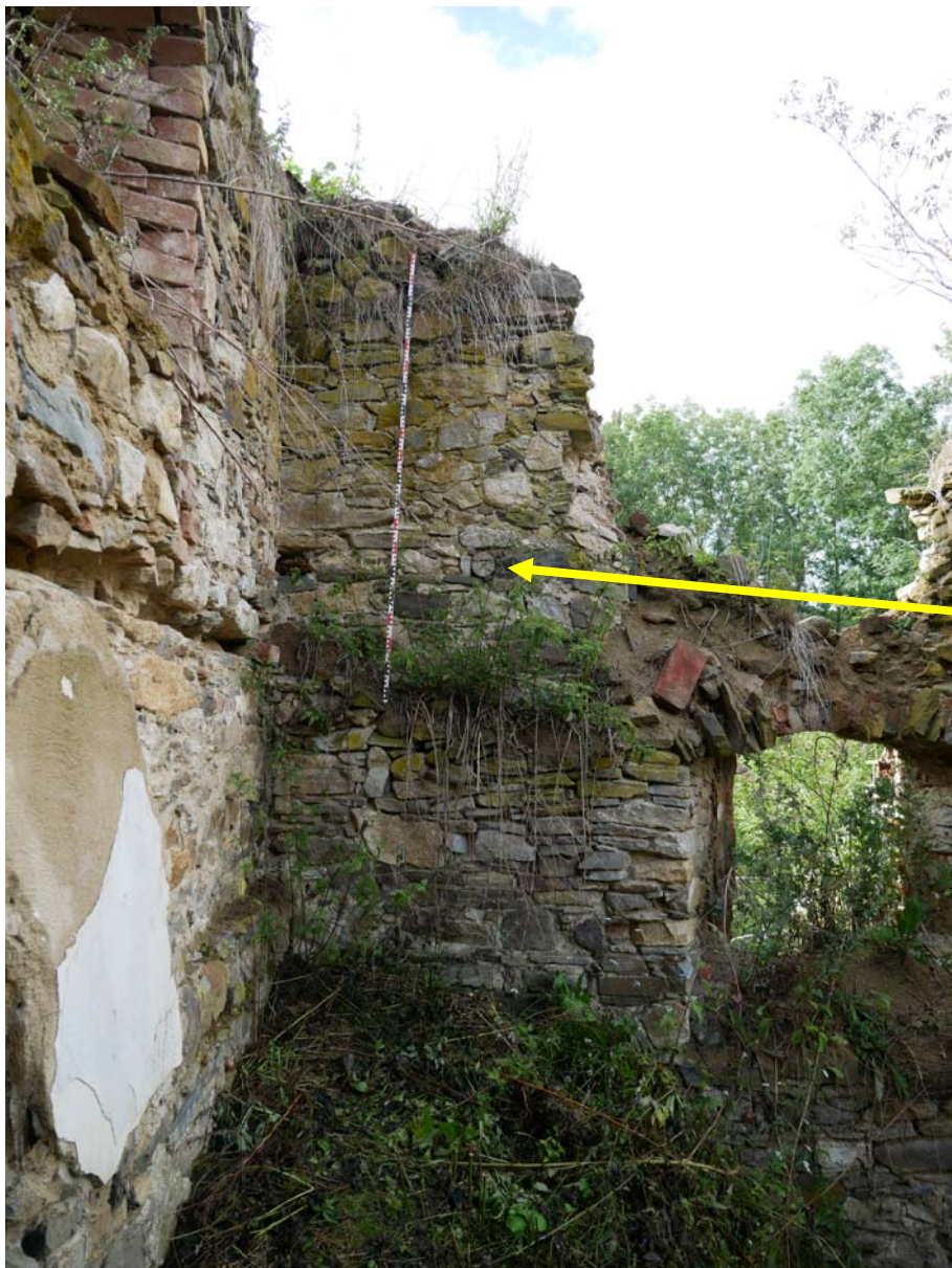
S stěna - lešení u SZ rohu Prvek C
